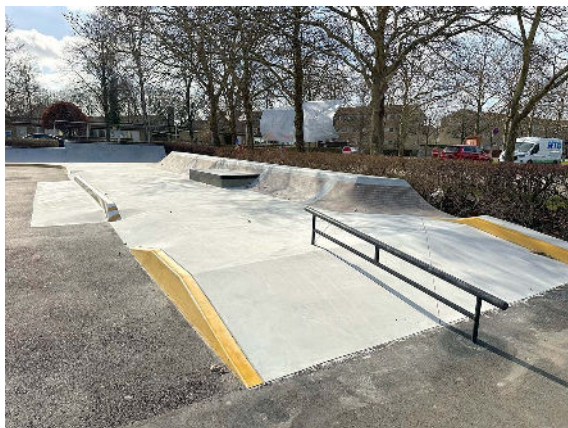
Skatepark i beton med ramper og rails.
